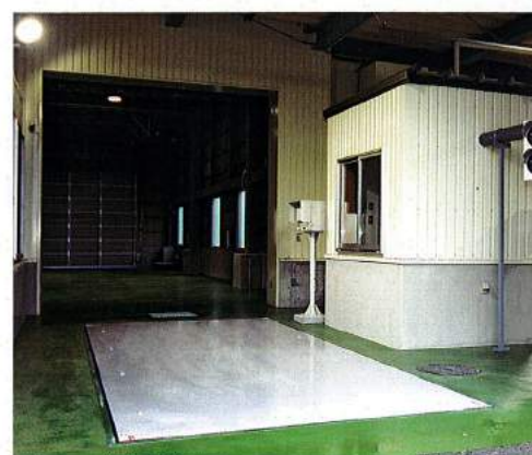
①ごみ計量機 ごみ収集車がごみ計量機で搬入されたごみの重さを計ります。
