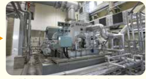
8 8 じょうきき 8 じょうきき 蒸気タービン発電設備 ボイラで発生した蒸気でタービン発電機を 回し、電気を作ります。
