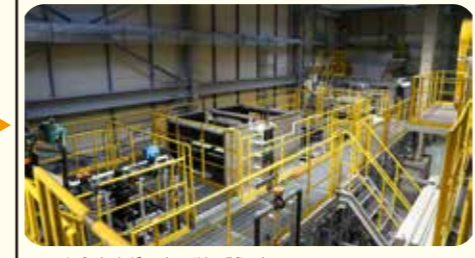
7 7 しょうきやくばいすいせんそうち 7 しょうきやくばいすいせんそうち 焼却灰水洗装置 (SMASHシステム) 水槽内で焼却灰を洗浄することで、焼却灰 をきれいにし、セメント原料に使用します。
