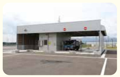
1 1 がいりょうき 1 がいりょうき ごみ計量機 ごみ収集車で運ばれてきたごみは、 ごみ計量機で重さを量ります。
