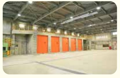
1 1 プラットホーム 1 プラットホーム ごみ収集車はプラットフォームに進入 し、ごみをごみピットへ投入します。
