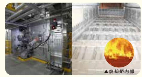
3 3 しょうきやくろ 3 しょうきやくろ 焼却炉 炉内へ入ったごみは、火格子の上を進みなが ら850℃以上の高温で燃やします。
